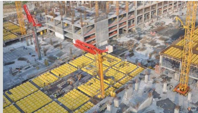
Çift yönlü nervür döşemeler inşaa etmekte kullanılan kaset kalıplar farklı ebatlarda üretilmektedir. Kalıp tasarımları plan içinde karedir ve kullanımı kolaydır, her türlü iskele sistemlerinde uygulanabilir.
